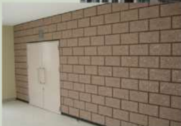
エントランスホール 改修後 仕上げ材：セラネオ
